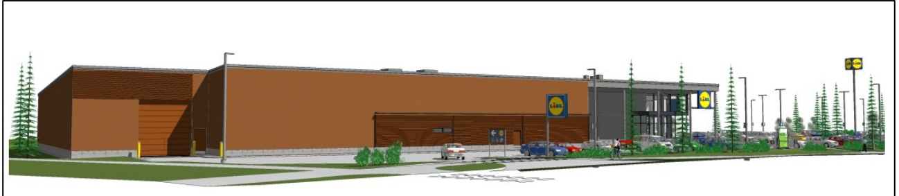
Kuva 35. Näkymä Metsokankaantieltä etelästä.
